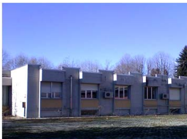
La costruzione ENEL su piazza Falcone e Borsellino
