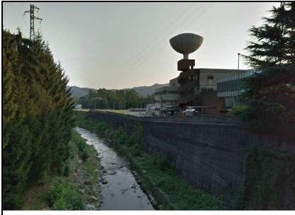
Vista zona Franchi da ponte Strona
